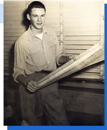
Jack Cogswell 1951 (Cogswell Sprinkler Co. Inc.)
